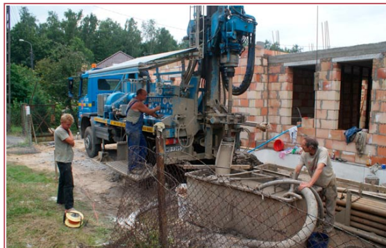
Fig. 1 Wykonywanie odwiertów pod kolektor pionowy
