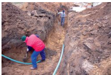
Układanie kolektora poziomego
