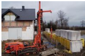
Wiercenie kolektora pionowego głębokiego
