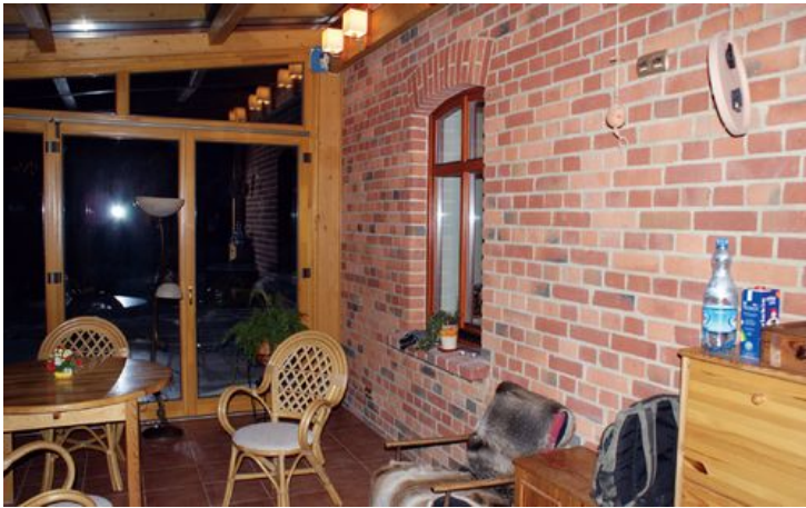
Przeszkolona weranda (ogród zimowy) ogrzewana jest ogrzewaniem podłogowym zasilanym przez pompę ciepła. Do zapewnienia w tym pomieszczeniu odpowiedniej temperatury potrzeba szacunkowo do 6,5 kW. Można by zmniejszyć tę wartość dzięki prawidłowemu zamontowaniu okien oraz uszczelek
