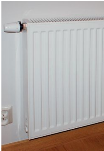
W domu Joanny i Patryka ogrzewanie podłogowe to tylko 30% instalacji, resztę stanowią grzejniki płytowe z podłączeniem środkowym
