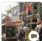
Pompa do betonu...
