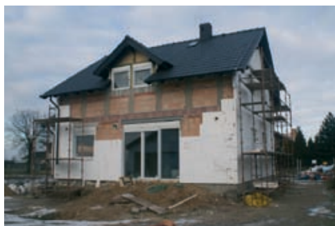
Fot. 2. Ocieplanie ścian styropianem.
