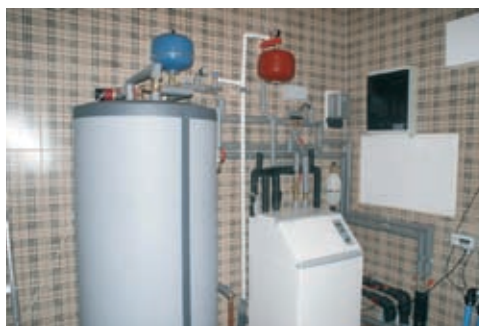
Fot. 3. Pompa ciepła i zasobnik c.w.u.
